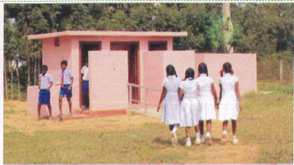
லுலுலுலு Toilet ஡லசலகூடம் / கழிவறை
