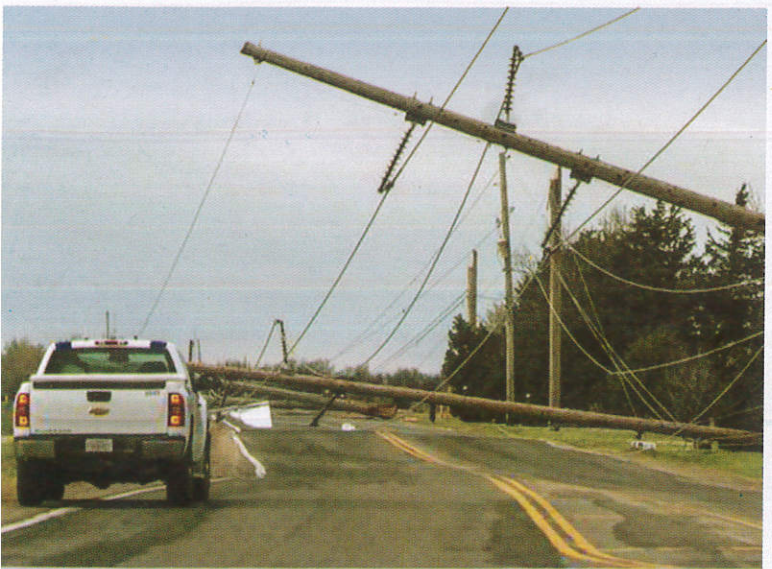
■ டூஸ்டி டிஸ்டர்ன்ட் லீவ்ஸ் லீவ்ஸ் Electric and Telephone lines get disrupted மின் மற்றும் தொலைபேசி கம்பங்கள் உடைந்து வீழ்தல்
