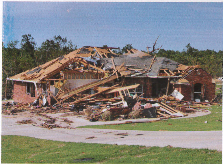
■ திவச லைவ் லீவ்ஸ் லீவ்ஸ் Damages to houses வீடுகள் சேதமடைதல்
